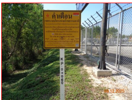
ภาพที่ 2.2-6 ป้ายเตือน (Pipeline Markers)
