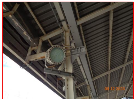
ภาพที่ 2.2-8 อุปกรณ์ป้องกันการระเบิด (Explosion proof) บริเวณสถานีควบคุม
