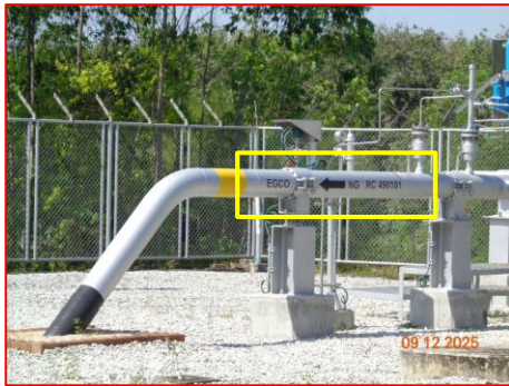
ภาพที่ 2.2-7 สัญลักษณ์แสดงตำแหน่งแนวท่อ โดยมีข้อความและหมายเลขโทรศัพท์แจ้งเหตุอย่างชัดเจน
