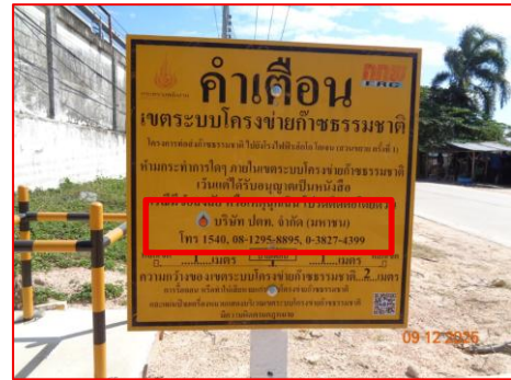
ภาพที่ 2.2-7 สัญลักษณ์แสดงตำแหน่งแนวท่อ โดยมีข้อความและหมายเลขโทรศัพท์แจ้งเหตุอย่างชัดเจน
