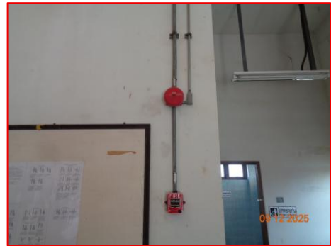
ภาพที่ 2.2-9 อุปกรณ์แจ้งเตือนและระงับเหตุอัคคีภัย (ต่อ)
