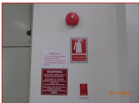
ภาพที่ 2.2-9 อุปกรณ์แจ้งเตือนและระงับเหตุอัคคีภัย
